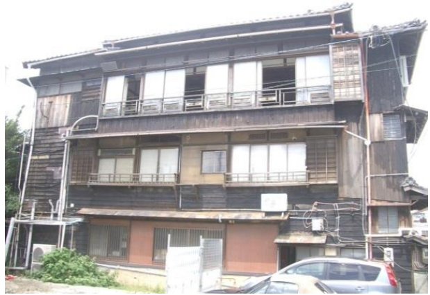
② 南景 (昭和10年築の3階建部分)
