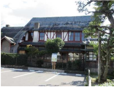
旧伊庭家住宅外観
