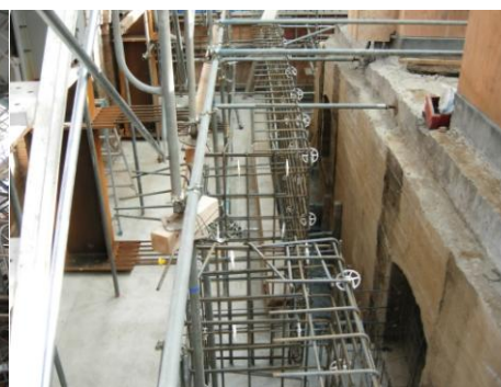
補強鉄骨柱脚と基礎
