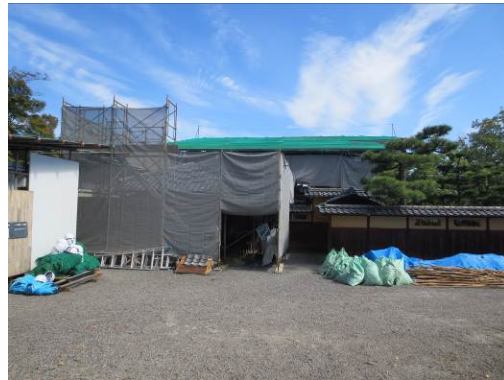
改修工事全景
