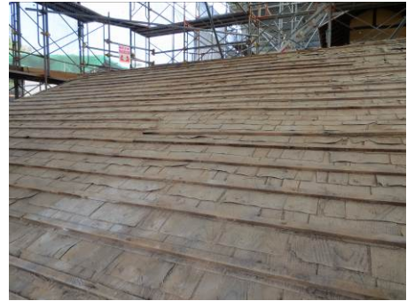
屋根改修工事
