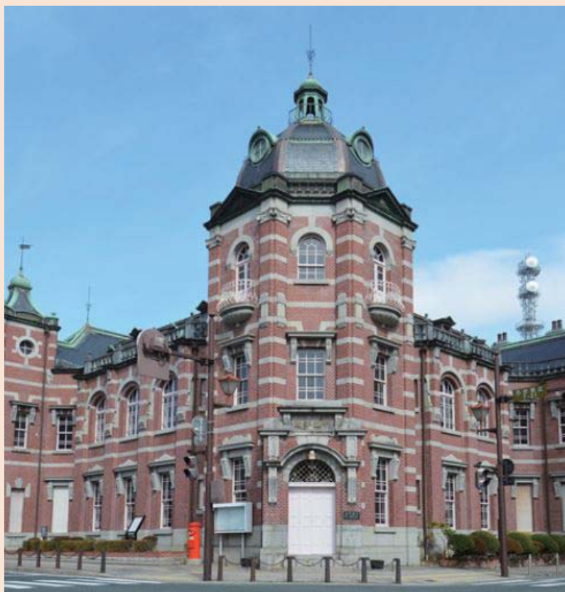
重要文化財若手銀行(旧盛岡銀行) 出典:若手銀行赤レンガ館ホームページ
